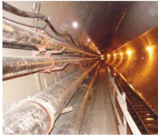
美國奧瑞岡州波特蘭，14 英寸及 16 英寸 #R-88 接頭應用於東區雨汙水合流溢流隧道工程。
